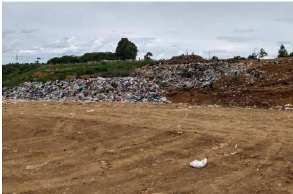
Figura 30 - Aterro Sanitário - Visita realizada no dia 02/02/2021.
