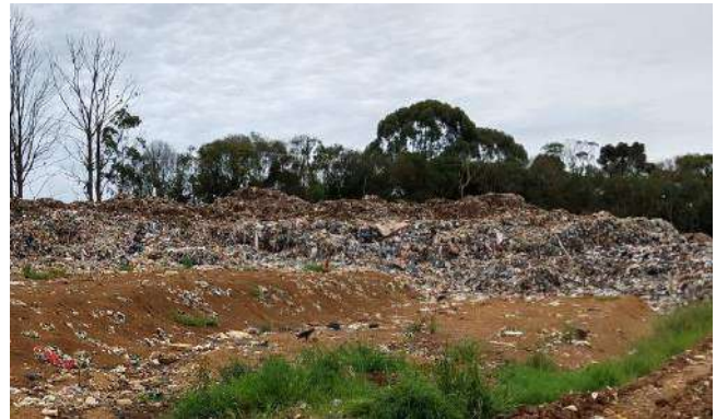
Figura 31 - Aterro Sanitário - Visita realizada no dia 15/04/2021.
