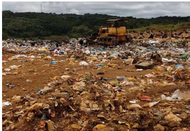
Figura 36 - Trator realizando a compactação.
