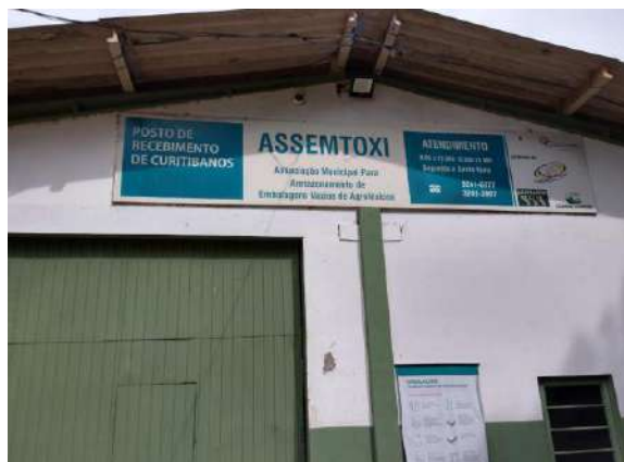
Figura 25 - Galpão da ASSEMTOXI.
