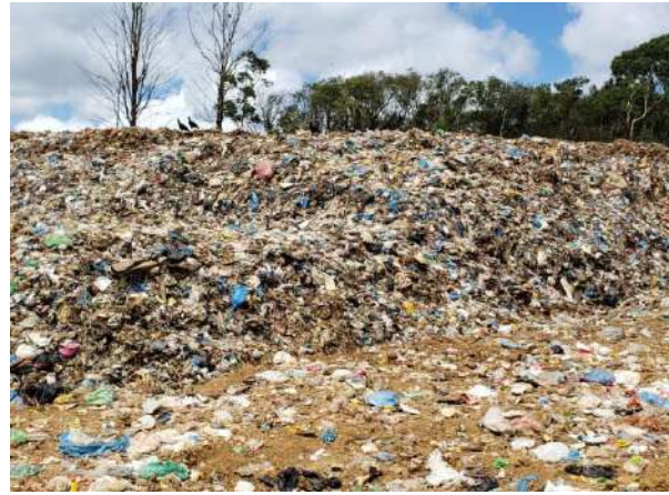
Figura 35 - Célula aguardando compactação para cobertura.
