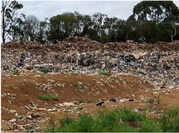
Figura 34 - Célula em processo de cobertura.
