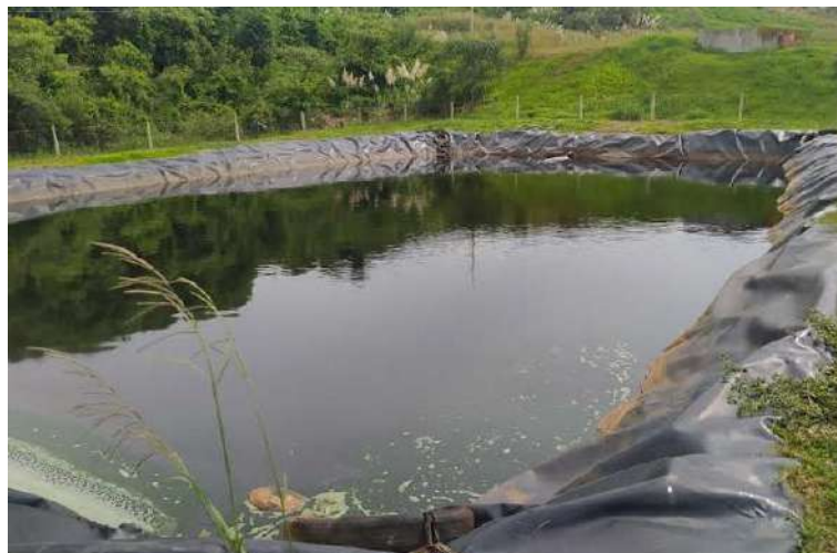
Figura 32 - Manta impermeável da lagoa de estabilização de forma regular.
