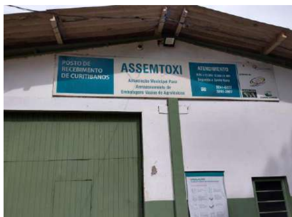
Figura 25 - Galpão da ASSEMTOXI.
