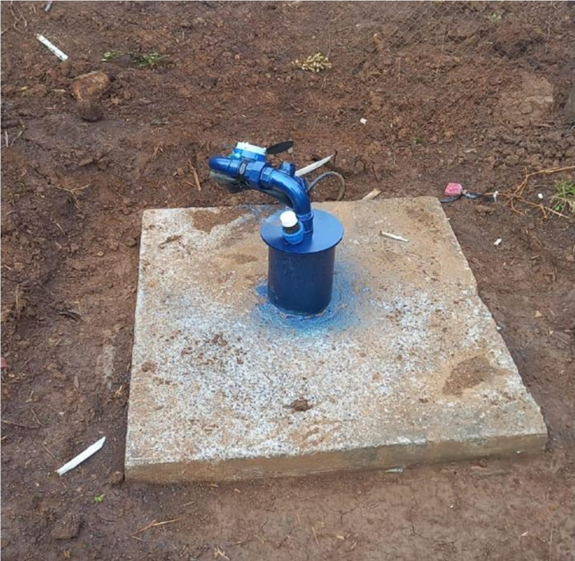
Foto 2 – Modelo da completação do poço com Tampão, Tubo de medição do nível e Hidrômetro de vazão adequada ao projeto.
