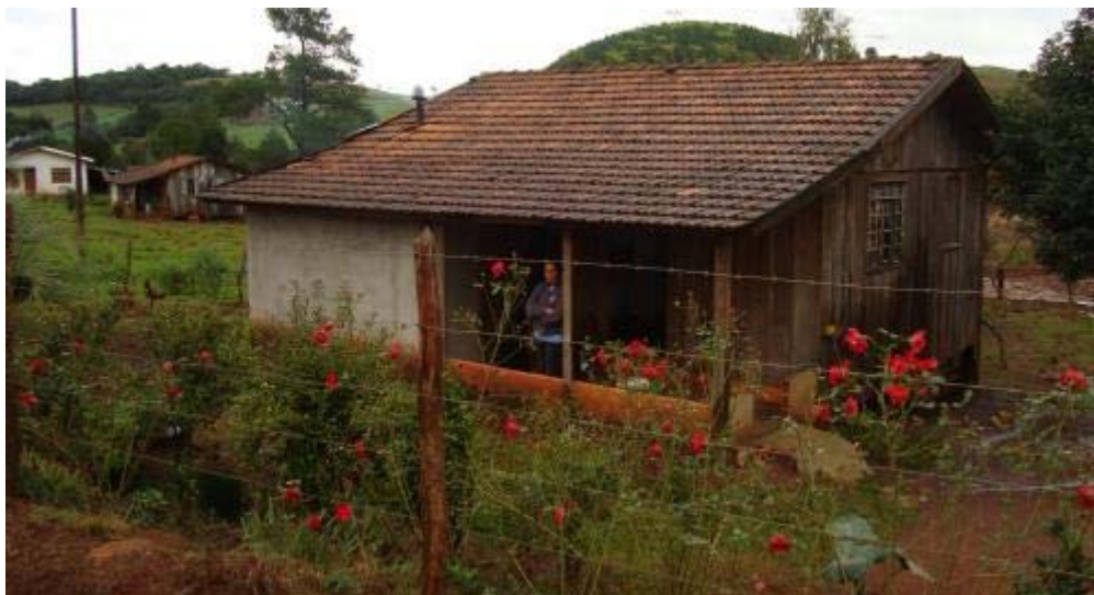
Figura 22: construção de banheiros nas residências do Microbacia Galegos com recursos do Microbacia.
