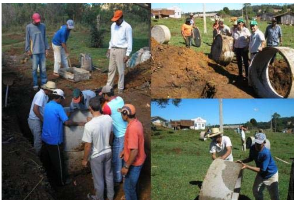
Figura 21: Instalação do sistema de esgoto na Microbacia Galegos, Recursos do Microbacia Fonte: Epagri, Microbacias 2, julho de 2010.
