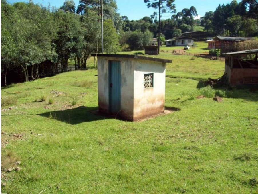
Figura 26: Captação subterrânea de água bruta no Poço 03 Fonte: Consórcio SOTEPA/IGUATEMI/AR
