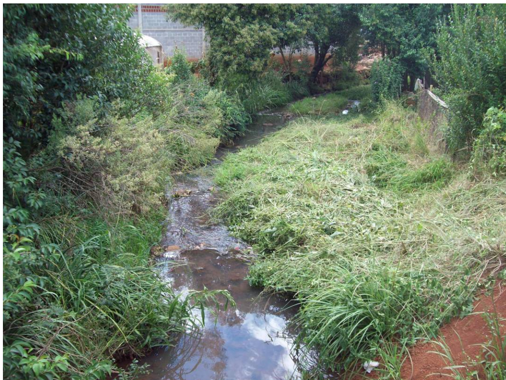
Figura 47: Vala de drenagem no Riacho Palmares Fonte: Consórcio SOTEPA/IGUATEMI/AR
