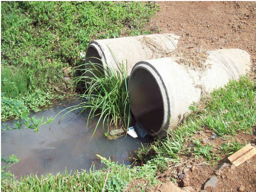
Figura 42: Saida das tubulações de drenagem no Rio Fartura Fonte: Consórcio SOTEPA/IGUATEMI/AR
