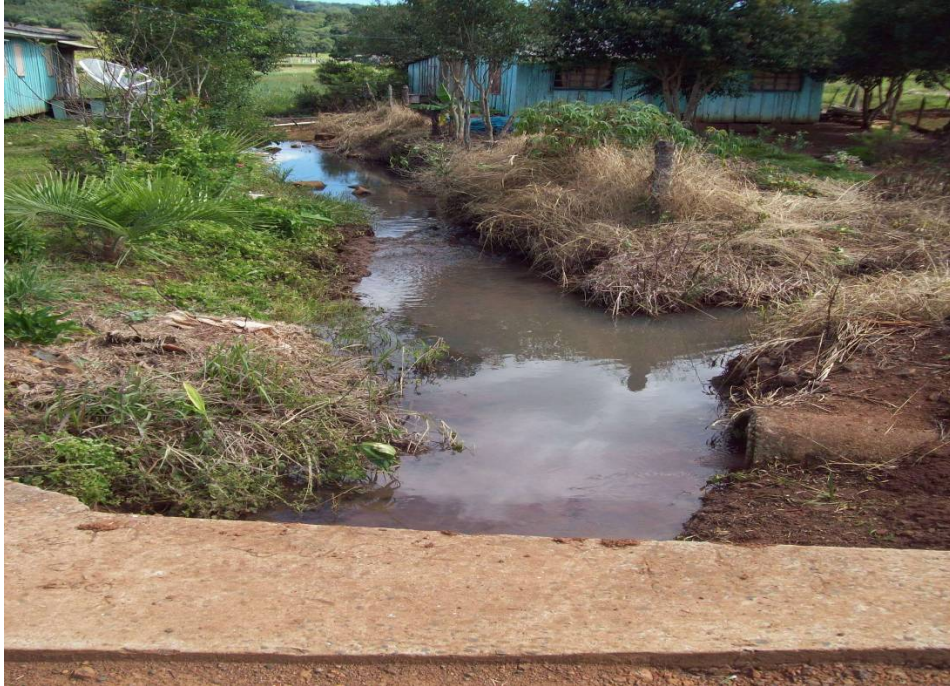
Figura 39: Ponto de alagamento do Rio Fartura Fonte: Consórcio SOTEPA/IGUATEMI/AR
