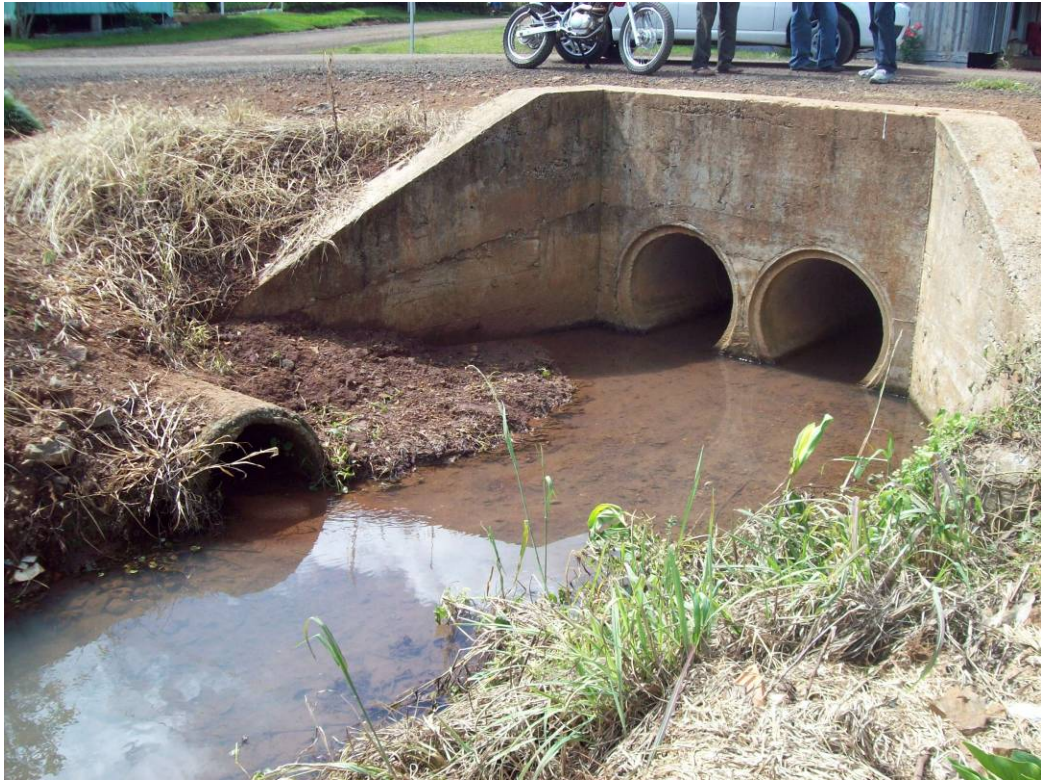
Figura 41: Bueiro Duplo na travessia da via no Rio Fartura Fonte: Consórcio SOTEPA/IGUATEMI/AR
