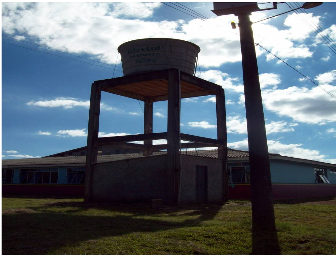
Figura 30: Reservatório R3 que atende a bairro Industrial de Brunópolis Fonte: Consórcio SOTEPA/IGUATEMI/AR
