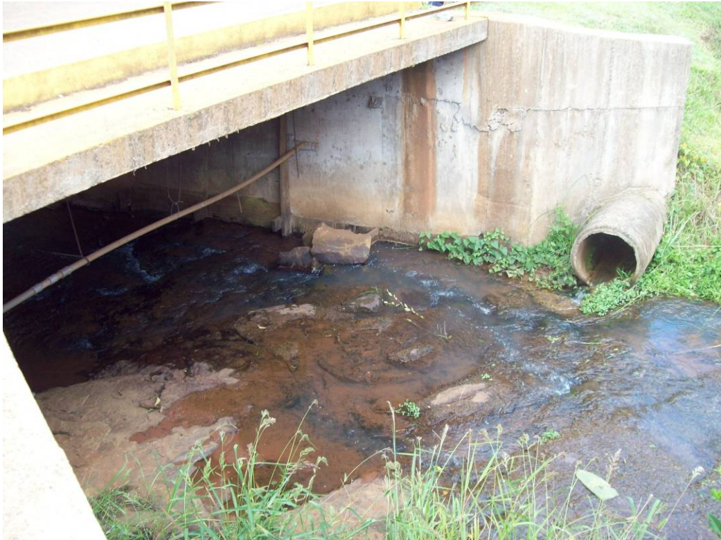
Figura 48: Ponto de estrangulamento da drenagem no Riacho dos Palmares Fonte: Consórcio SOTTEPA/IGUATEMI/AR
