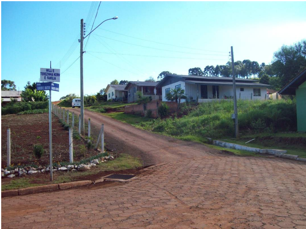
Figura 53: Ponto sujeito a alta carga de escoamento pluvial superficial Fonte: Consórcio SOTEPA/IGUATEMI/AR
